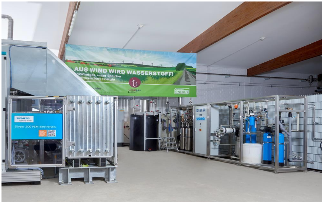
Abbildung 82: 1,25 MW el PEM-Elektrolyseur (links) mit Wasseraufbereitung (rechts) beim realen Betrieb in der Stadt Haßfurt [79].
