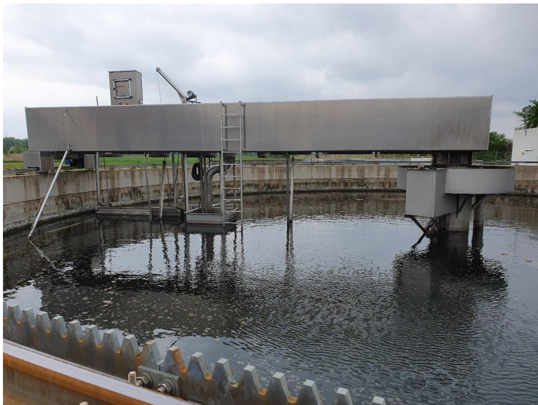
Abbildung 31: Nachklärbecken
