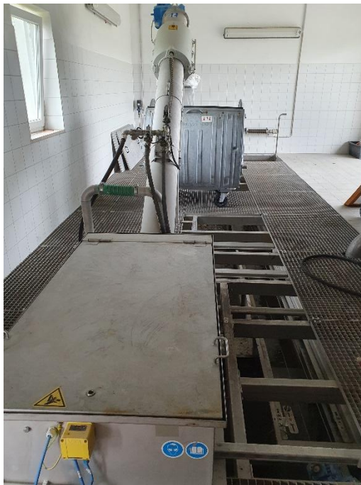
Abbildung 25: Rechen-Sandfang Kompaktanlage
