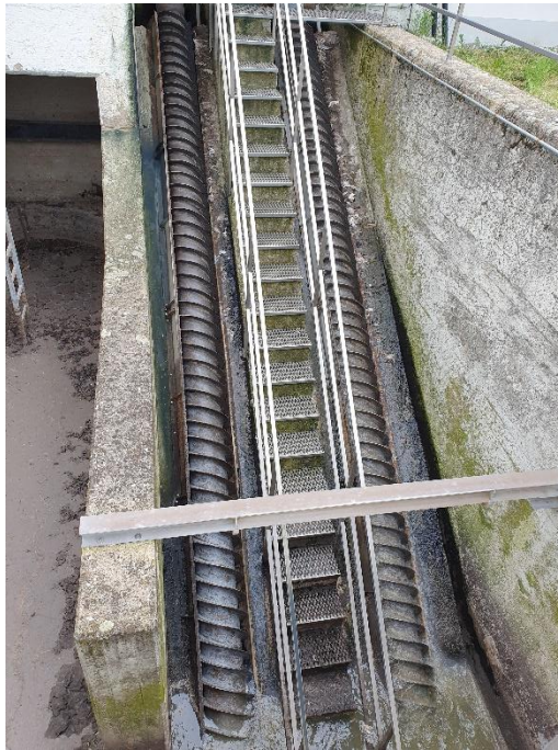
Abbildung 24: Zulaufhebework
