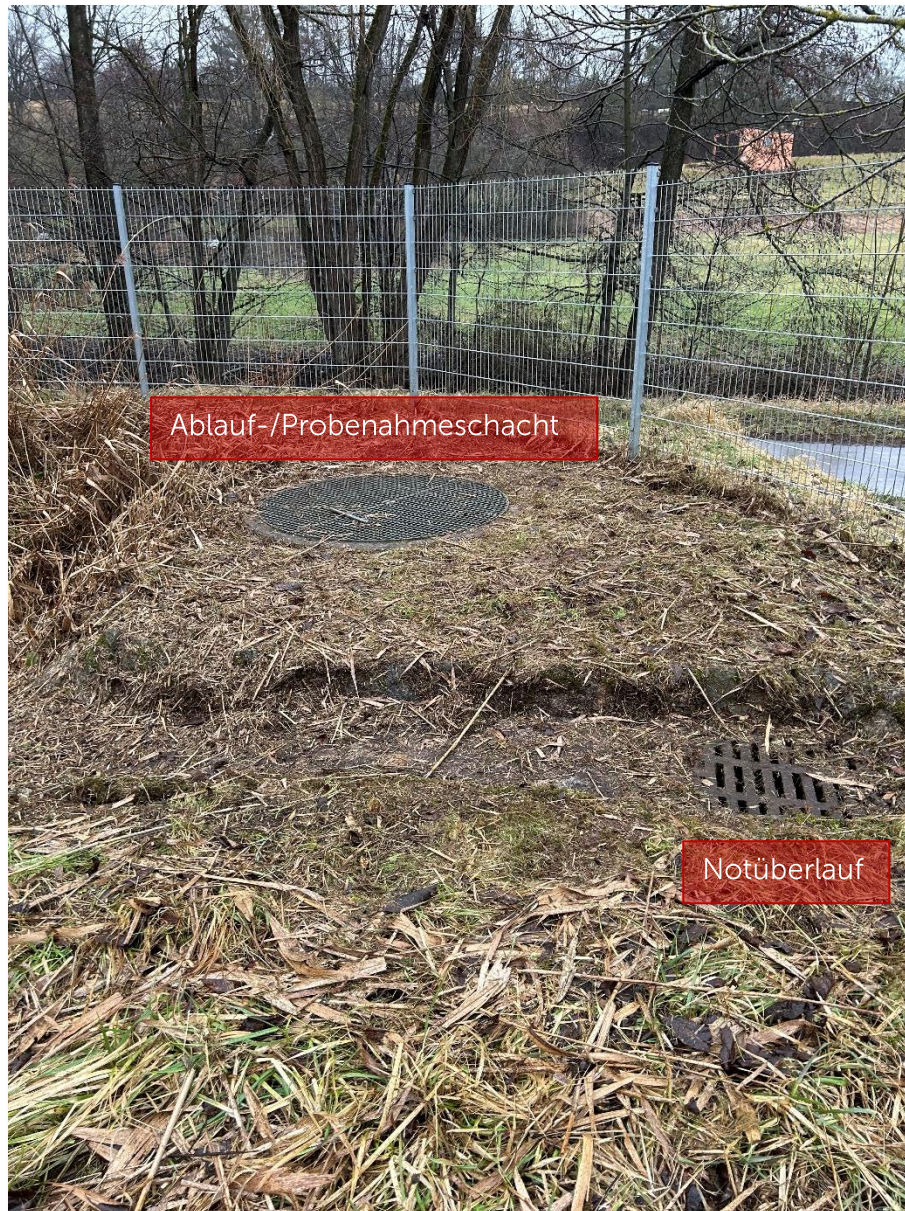
Abbildung 5: Drosselbauwerk und Notüberlauf
