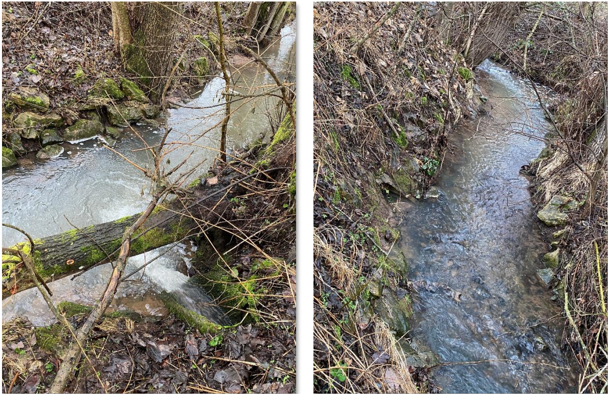
Abbildung 7: Einleitstelle 1 (links), Entlastungskanal RBF (rechts)
